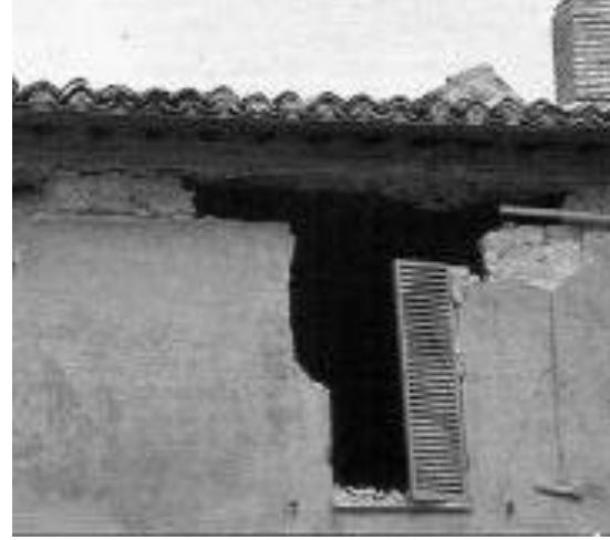
تظهر انهيار محلي في الجزء العلوي من الجدار تشققات كبيرة منتشرة في منطقة تواضع الجائز بسبب الاجهادات الكبيرة ناتجة عن الدفع من السقف.
