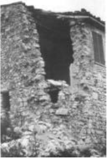
انهيار محلي أو كلي في الزوايا أو تشوهات كبيرة في الجدران
